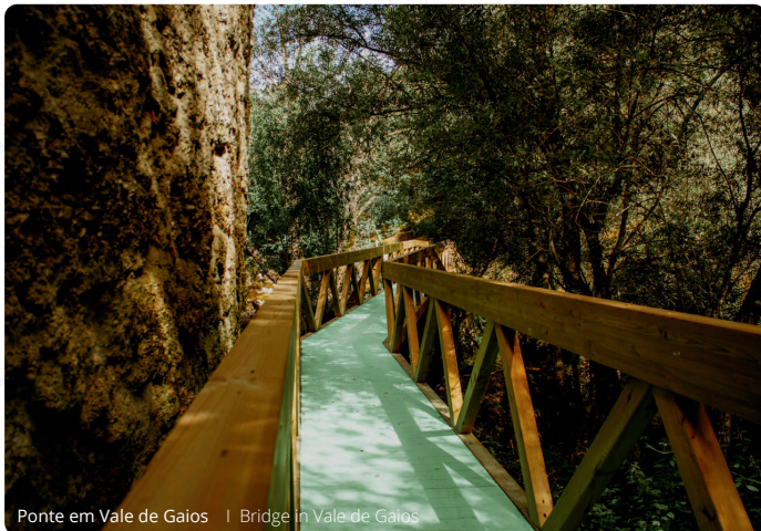
Ponte em Vale de Gaios | Bridge in Vale de Gaios
